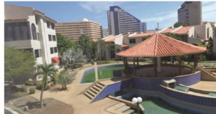
Fachada Conjunto Residencial Isla del Rey - Foto: Noraima Franquíz
