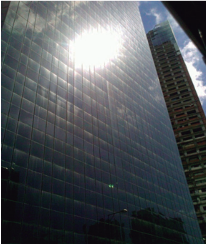
Foto N°6: Fachada sur de la Torre Mercantil, edificio ubicado en la avenida Andrés Bello de Caracas. Nótese la exposición de su fachada a la luz solar, que en este sistema de fachadas implica un alto consumo de energía en sistemas de enfriamiento, que hace al edificio vulnerable por exposición pasiva, no solo por el efecto de los rayos del Sol, sino por la dependencia del suministro eléctrico. El período de mayor exposición es en las mañanas, en los meses de diciembre a abril. Foto: Jesús Delgado, 2011.
