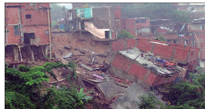
Foto N°3: Derrumbe en un “cerro” de Caracas. Nótese la rigidez y peso de las viviendas, la debilidad de los techos y la inadecuada configuración y orden de la edificación, en la que la masa está concentrada en la parte alta. (S/F).
