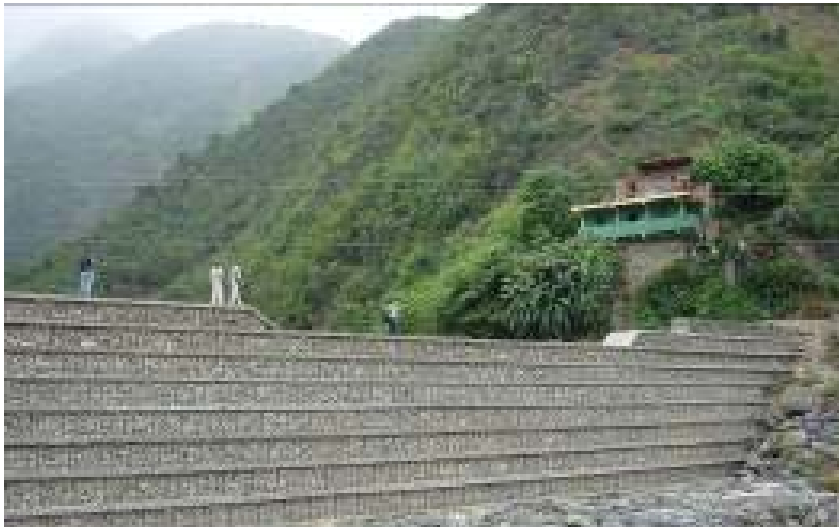
Presas cerrada de gaviones en Qda. San José de Galipán (Macuto)
