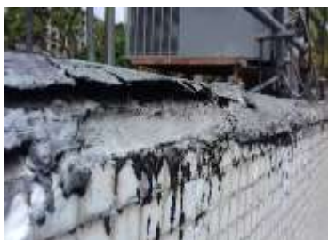
Vistas de deterioro: impermeabilización del techo, friso interno del techo, carencia de piezas sanitarias
