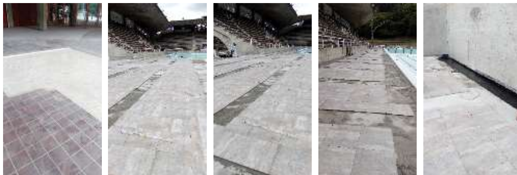
Se puede observar la instalación de la cerámica, se observan las franjas de 45 cms, para el vaciado de concreto en la última foto a mano derecha un tramo de la impermeabilización de la playa
