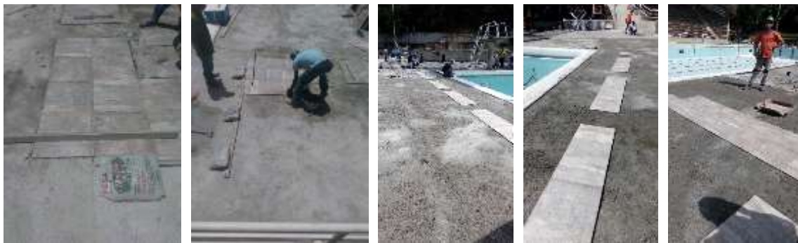
Instalación de la cerámica de en la Playa del complejo de piscina
