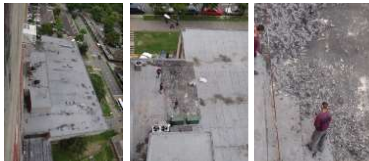
Proceso de demolición del manto asfáltico
