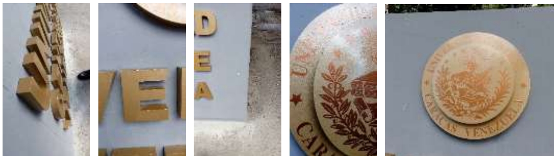
Vista de las nuevas letras corporeas instaladas en los accesos a la CUC
