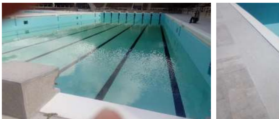
Se comenzo con el llenado de la piscina Olimpica y se estan puliendo las pletinas de bronce que se encuentran en el borde de ambas piscinas
