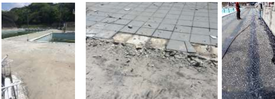
Se finalizó la demolición de la cerámica y manto de la playa del complejo de piscina
