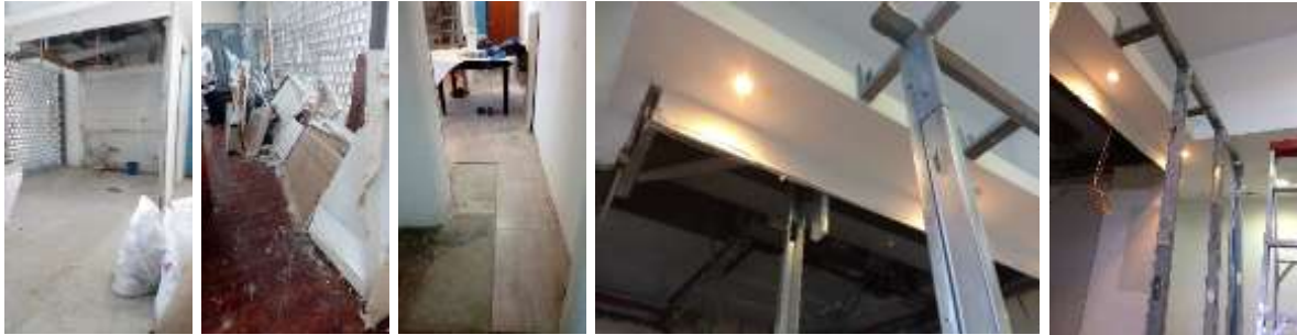
Demolición del area de la cocina. Instalacion de pared de Drywall
