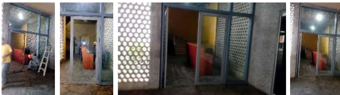
Instalacion de las puerta de seguridad en el Hall del Edificio del Rectorado
