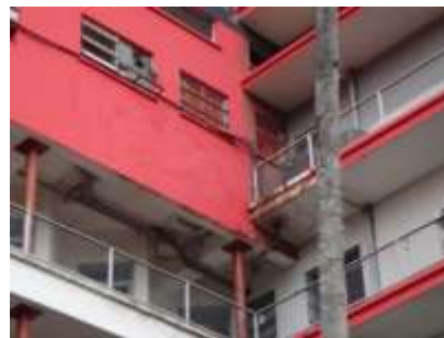
Detalles en friso ocasionado por filtraciones activas en fachadas internas y externas sin reparar
