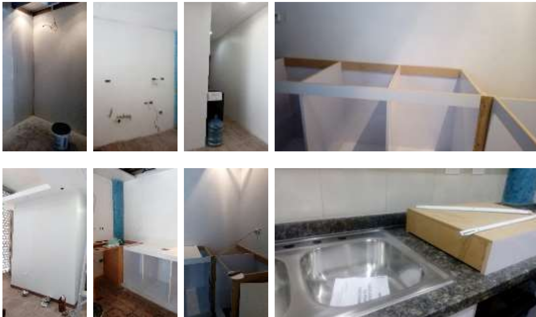
Demolición del area de la cocina. Instalacion de pared de Drywall
