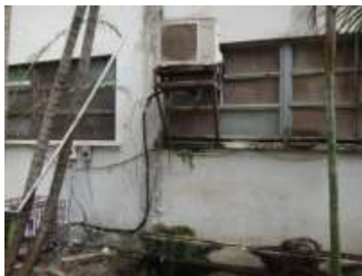
Detalles en friso ocasionado por filtraciones activas en fachadas internas y externas sin reparar
