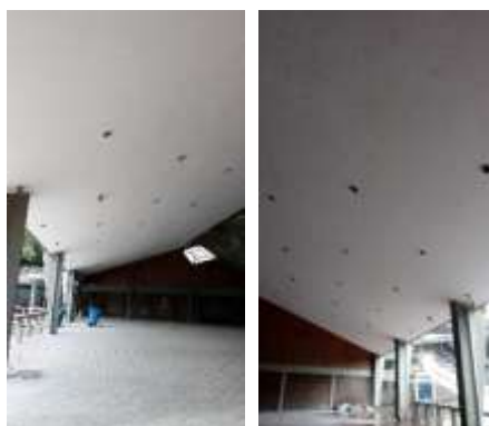
Se realizó la impermeabilización del área del cafetín, Se observó la desaparición de filtraciones
