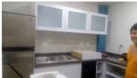
Instalación de los muebles de la cocina
