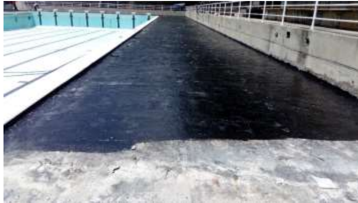
Impermeabilización de la playa del Complejo de Piscina de la Dirección de Deportes de la UCV
