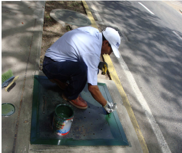
Esmalte en tapa metálica
