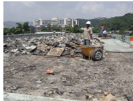
Demolición de manto y pendiente. Edificio Rectorado
