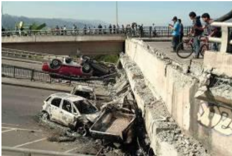
Imagen del Puente Llacolén al 27.02
