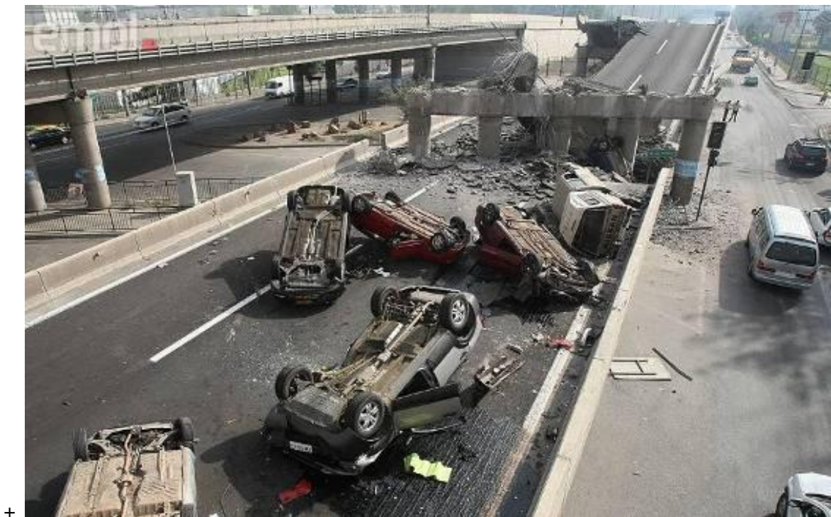
Autopista Vespucio Sur, Santiago.
