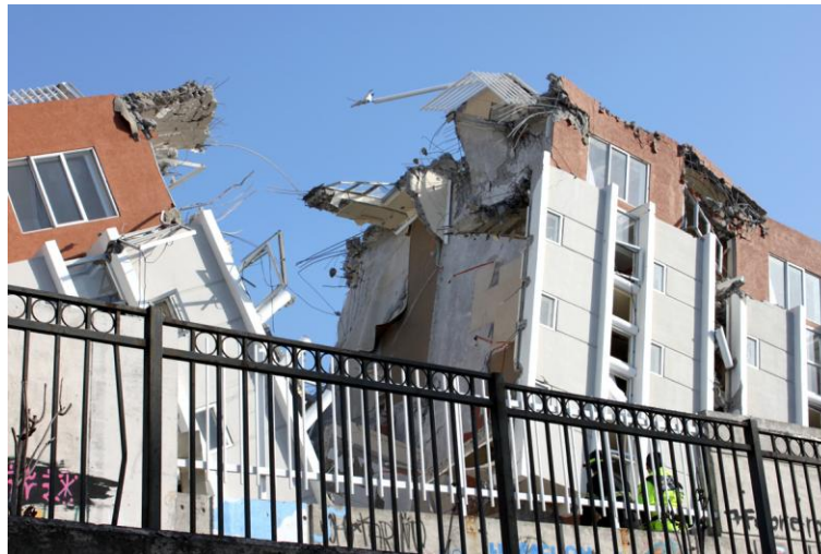
Edificio azotado por terremoto, Concepción
